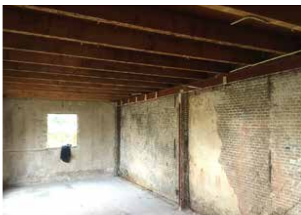
Restauratie van het karottenfabriekje Kralingse Plas.
