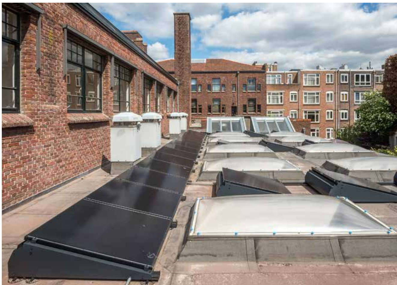
Voormalige drukkerij Wyt: verduurzaming en groot onderhoud dak en achtergevel
